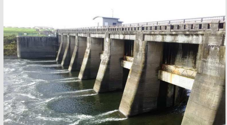
関宿水門（写真奥には関宿閘門がある）
