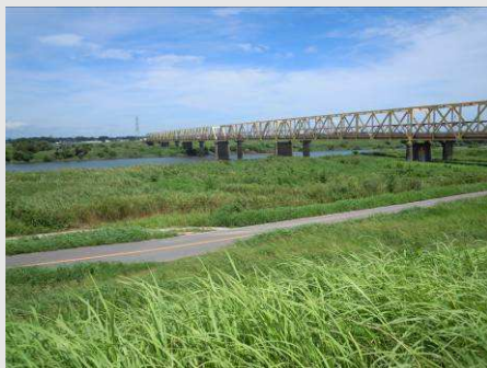
利根川と芽吹大橋
